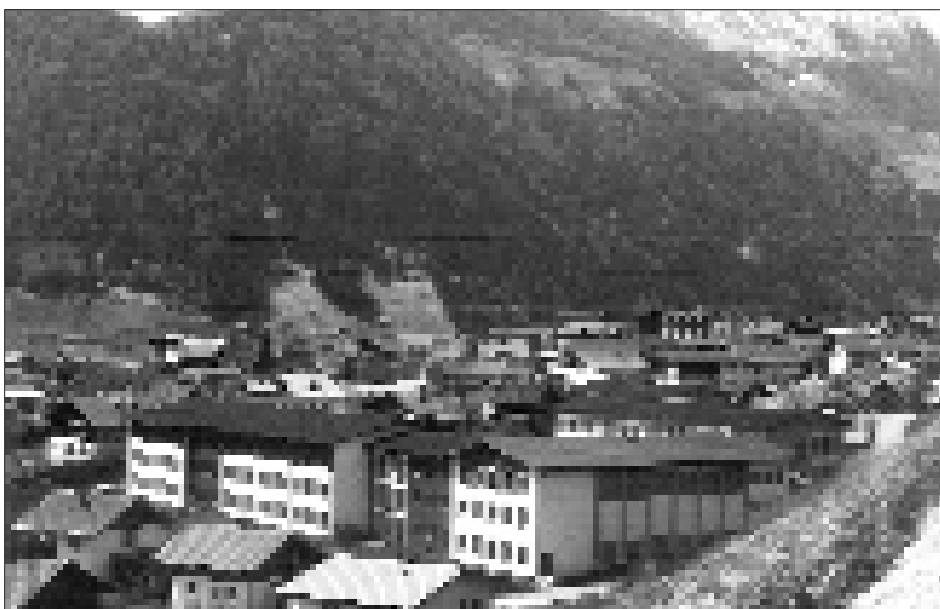
Das moderne Matreier Schulzentrum. Die Volksschule wurde am 16. September 1961, die Hauptschule am 19. Jänner 1971 eingeweiht. Foto: Lottersberger, Matrei i. O.
